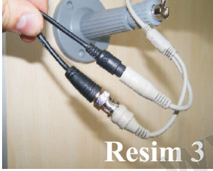
Kablo uçlarının kameraya bağlanması. (resim 3)
